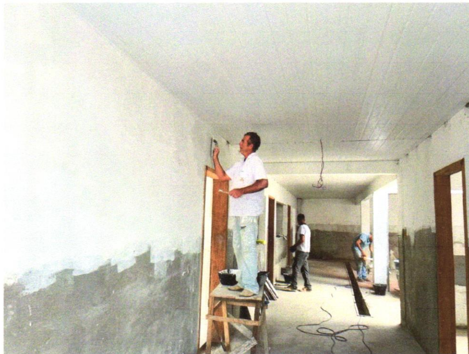
Foto 35 APLICAÇÃO E LIXAMENTO DE MASSA LÁTEX EM PAREDES, UMA DEMÃO. AF_06/2014
