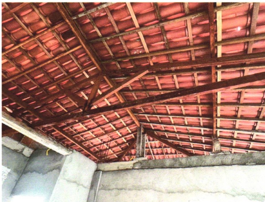
Foto 39 - TELHAMENTO COM TELHA CERÂMICA DE ENCAIXE, TIPO PORTUGUESA, COM ATÉ 2 ÁGUAS, INCLUSO TRANSPORTE VERTICAL. AF_07/2019
