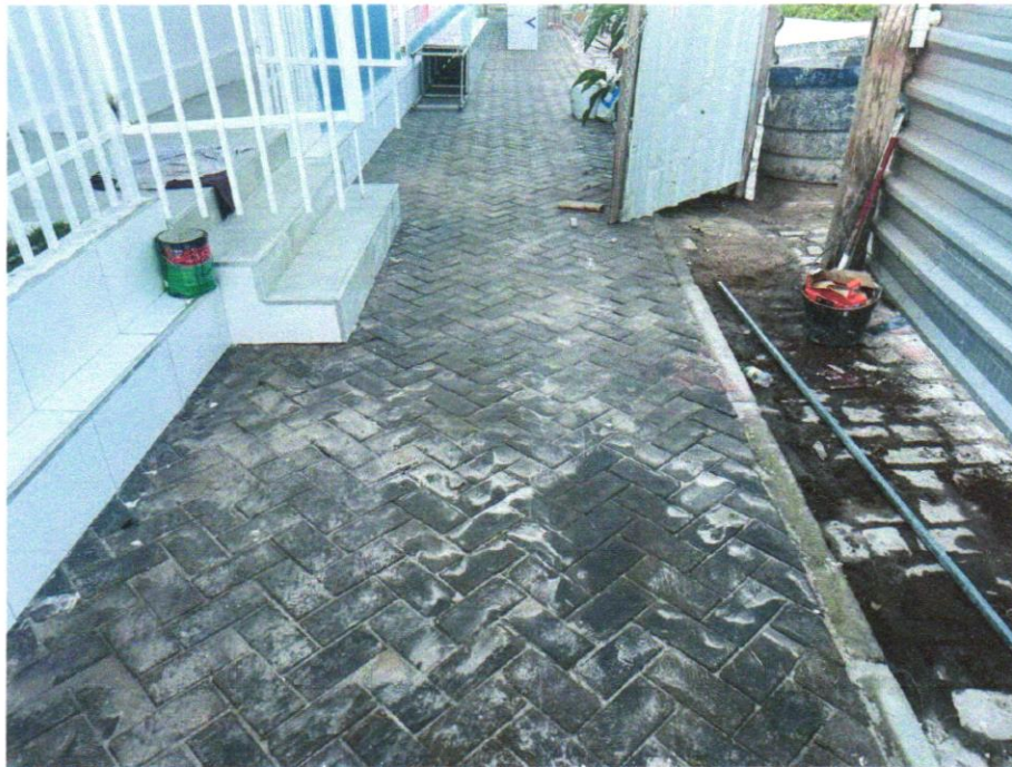
Foto 33 - EXECUÇÃO DE PASSEIO EM PISO INTERTRAVADO, COM BLOCO RETANGULAR COR NATURAL DE 20 X 10 CM, ESPESSURA 6 CM. AF_12/2015
