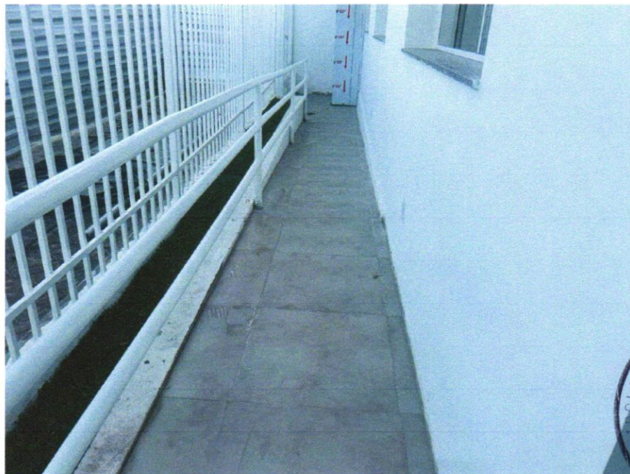
Foto 34 - Rampa padrão para acesso de deficientes a passeio público, em concreto simples Fck=25MPa, desmoldada, com pintura indicativa em novacor, 02 demãos
