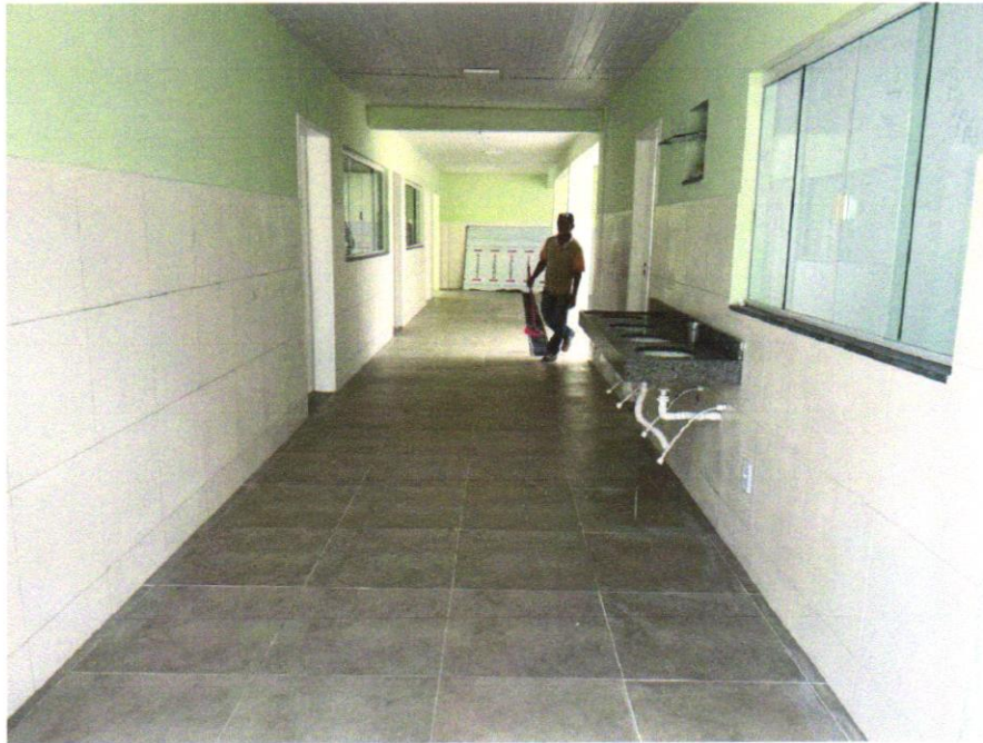
Foto 27 - Revestimento cerâmico para piso ou parede, 30 x 60 cm, porcelanato, linha white home, antártida, Portobello ou similar, aplicado com argamassa industrializada ac-i, rejuntado, exclusive regularização de base ou emboço
