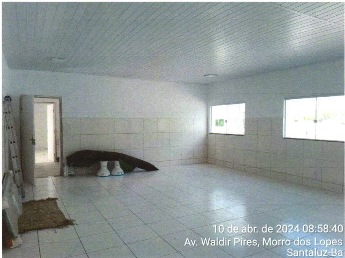
Foto 29 – Revestimento cerâmico para piso ou parede, 43 x 43 cm, Arielle, linha riviera, cor branca mate, ou similar, PEI-4, aplicado com argamassa industrializada ac-ii, rejuntado, exclusive regularização de base ou emboço
