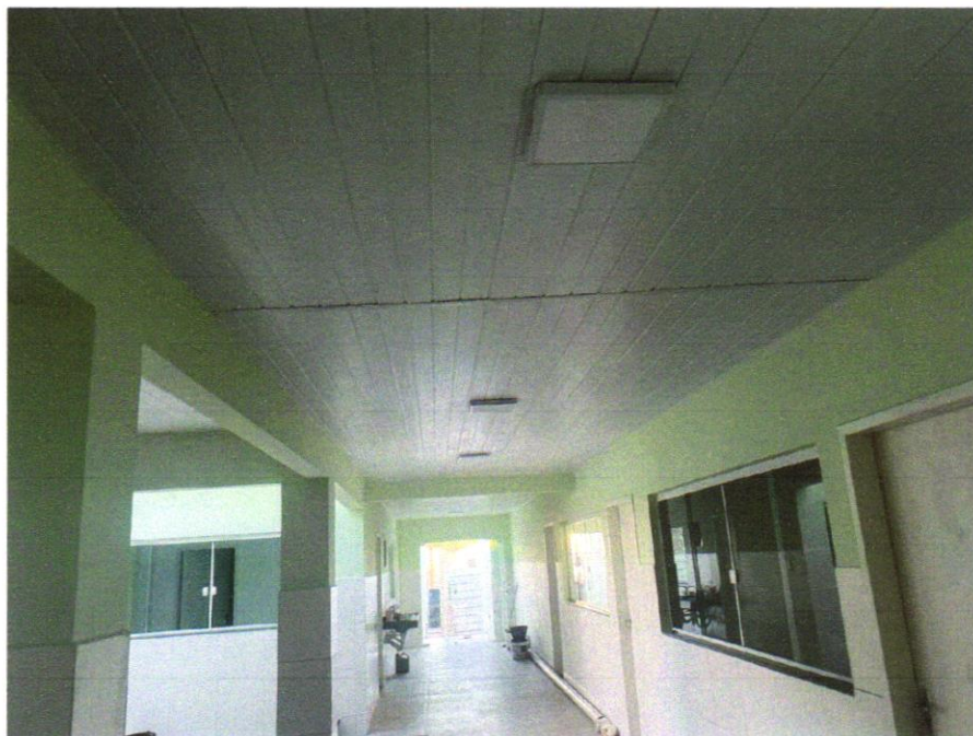
Foto 42 - Forro de pvc, em réguas de 10 ou 20 cm, aplicado, inclusive estrutura para fixação (perfis em PVC) marca Araforros ou similar, instalado - Rev 06_10/2021
