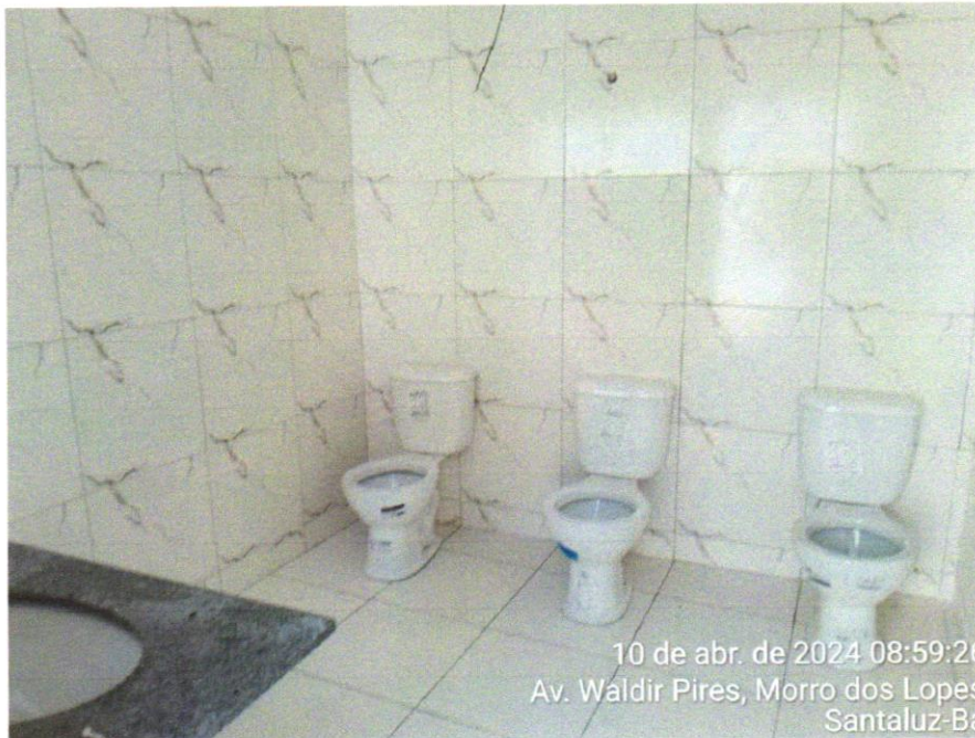
Foto 14 - VASO SANITÁRIO SIFONADO COM CAIXA ACOPLADA LOUÇA BRANCA, INCLUSO ENGATE FLEXÍVEL EM PLÁSTICO BRANCO, 1/2 X 40CM - FORNECIMENTO E INSTALAÇÃO. AF_01/2020
