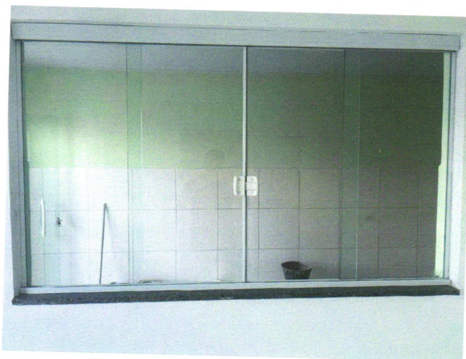
Foto 10 - JANELA DE ALUMÍNIO DE CORRER COM 4 FOLHAS PARA VIDROS, COM VIDROS, BATENTE, ACABAMENTO COM ACETATO OU BRILHANTE E FERRAGENS. EXCLUSIVE ALIZAR E CONTRAMARCO, FORNECIMENTO E INSTALAÇÃO. AF_12/2019
