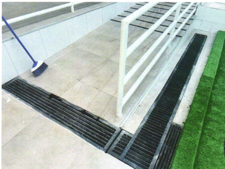
Foto 44 - GRELHA DE FERRO FUNDIDO SIMPLES COM REQUADRO, 200 X 1000 MM, ASSENTADA COM ARGAMASSA 1 : 3 CIMENTO: AREIA - FORNECIMENTO E INSTALAÇÃO. AF_08/2021
