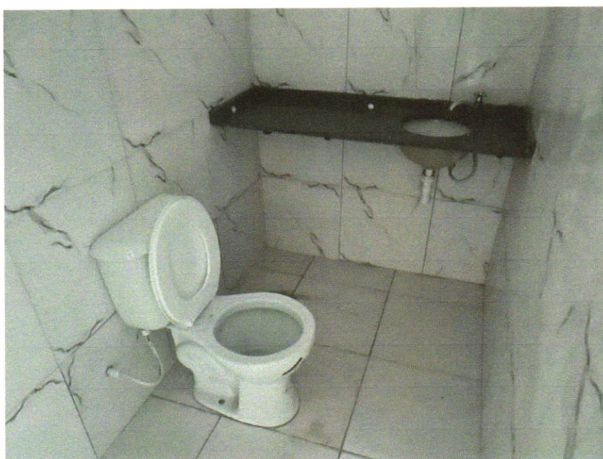
Foto 16 - BANCADA GRANITO CINZA, 50 X 60 CM, INCL. CUBA DE EMBUTIR OVAL LOUÇA BRANCA 35 X 50 CM, VÁLVULA METAL CROMADO, SIFÃO FLEXÍVEL PVC, ENGATE 30 CM FLEXÍVEL PLÁSTICO E TORNEIRA CROMADA DE MESA, PADRÃO POPULAR - FORNEC. E INSTALAÇÃO. AF_01/2020
