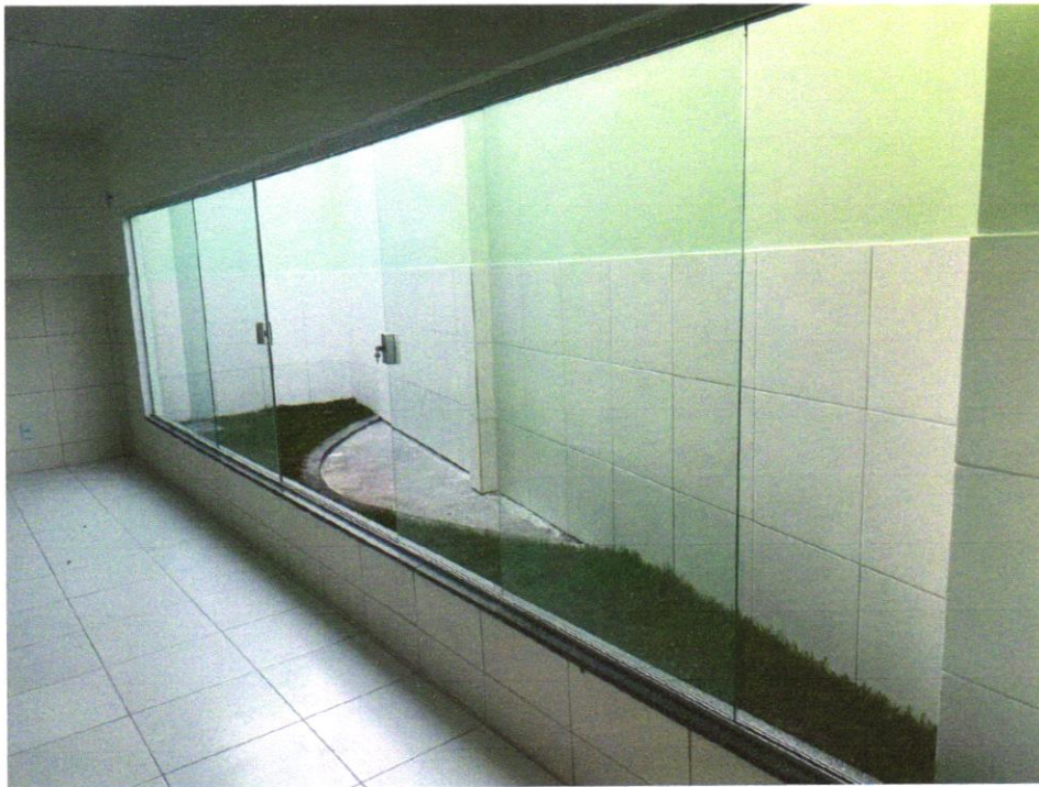
Foto 11 - PORTA DE CORRER DE ALUMÍNIO, COM DUAS FOLHAS PARA VIDRO, INCLUSO VIDRO LISO INCOLOR, FECHADURA E PUXADOR, SEM ALIZAR. AF_12/2019
