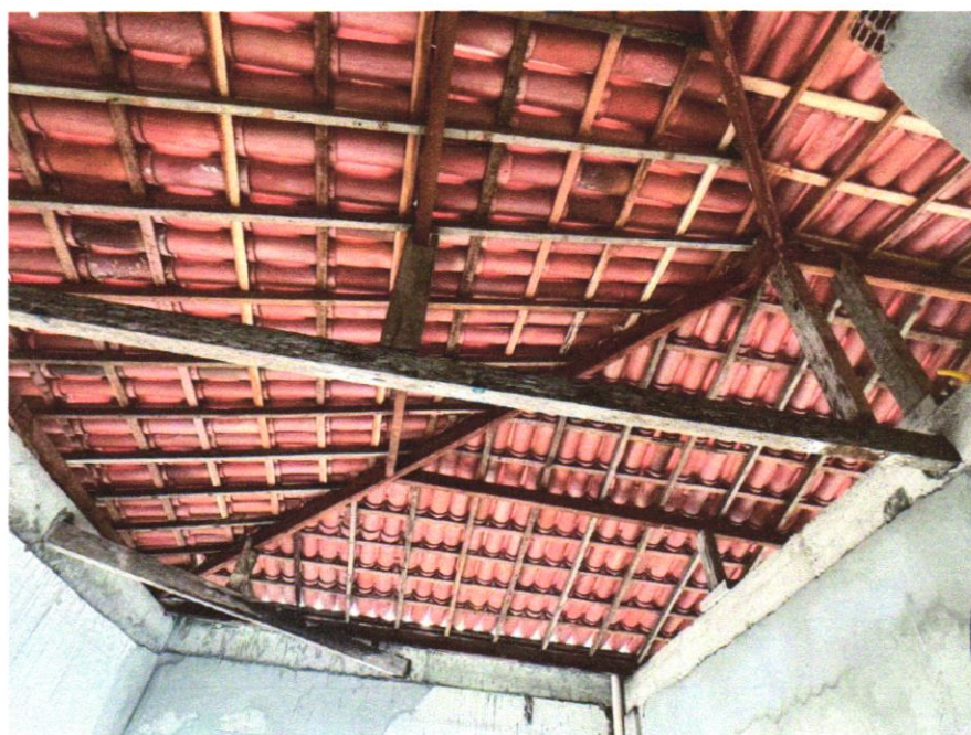
Foto 40 - TRAMA DE MADEIRA COMPOSTA POR RIPAS, CAIBROS E TERÇAS PARA TELHADOS DE ATÉ 2 ÁGUAS PARA TELHA CERÂMICA CAPA-CANAL, INCLUSO TRANSPORTE VERTICAL. AF_07/2019
