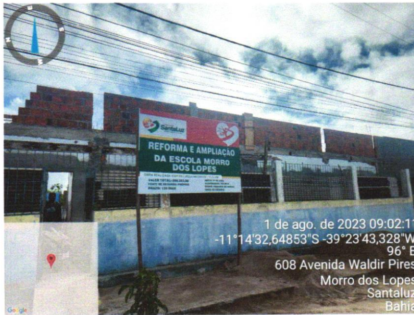
Foto 01 - ALVENARIA DE VEDAÇÃO DE BLOCOS VAZADOS DE CONCRETO DE 9X19X39CM (ESPESSURA 9CM) DE PAREDES COM ÁREA LÍQUIDA MAIOR OU IGUAL A 6M² SEM VÃOS E ARGAMASSA DE ASSENTAMENTO COM PREPARO MANUAL. AF_06/2014
