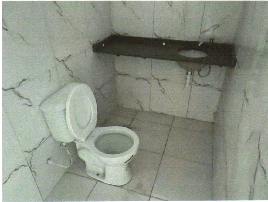
Foto 13 - VASO SANITÁRIO SIFONADO COM CAIXA ACOPLADA LOUÇA BRANCA, INCLUSO ENGATE FLEXÍVEL EM PLÁSTICO BRANCO, 1/2 X 40CM - FORNECIMENTO E INSTALAÇÃO. AF_01/2020
