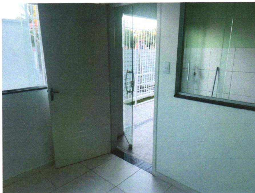
Foto 22 – INTERRUPTOR SIMPLES (1 MÓDULO), 10A/250V, INCLUINDO SUPORTE E PLACA - FORNECIMENTO E INSTALAÇÃO. AF_12/2015
