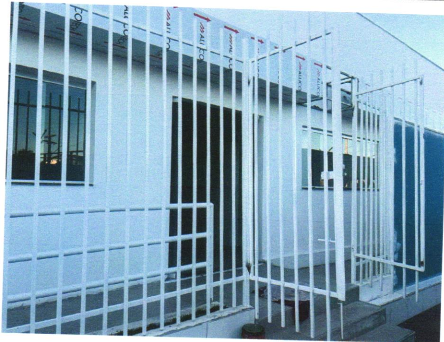
Foto 09 - Portão de ferro de abrir, quadro em tubo de aço galv. 1 1/2", barra quadrada 1/2" na vertical e barra chata de 1 x 3/16" na horizontal, inclusive dobradiças e e ferrolho
