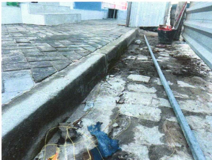
Foto 32 - ASSENTAMENTO DE GUIA (MEIO-FIO) EM TRECHO CURVO, CONFECCIONADA EM CONCRETO PRÉ-FABRICADO, DIMENSÕES 80X08X08X25 CM (COMPRIMENTO X BASE INFERIOR X BASE SUPERIOR X ALTURA), PARA URBANIZAÇÃO INTERNA DE EMPREENHIMENTOS. AF_06/2016
