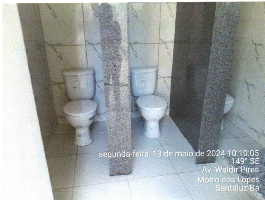
Foto 02 – DIVISORIA SANITÁRIA, TIPO CABINE, EM MÁRMORE BRANCO POLIDO, ESP = 3CM, ASSENTADO COM ARGAMASSA COLANTE AC III-E, EXCLUSIVE FERRAGENS. AF_01/2021
