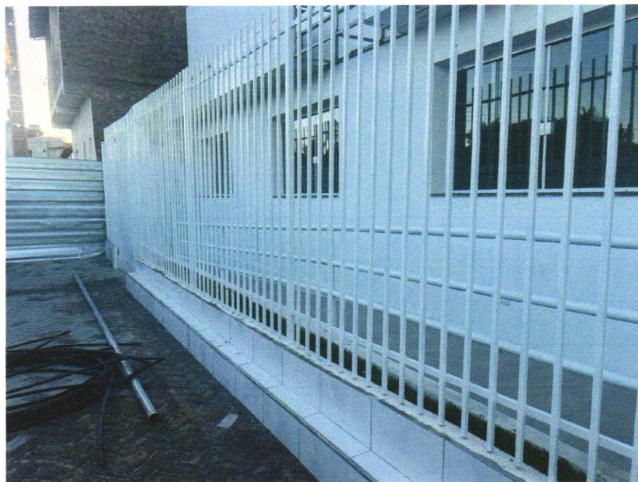
Foto 38 - Pintura de acabamento em superfícies metálicas com aplicação de 02 demãos de tinta esmalte epoxi branco, e = 35 micra p/ demão-
