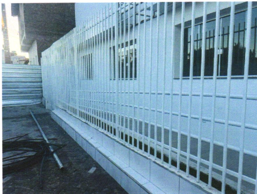
Foto 08 - Grade de ferro c/ gradil em barra chata 3/4" x 1/8", inclusive ferrolho e dobradiças conforme desenho
