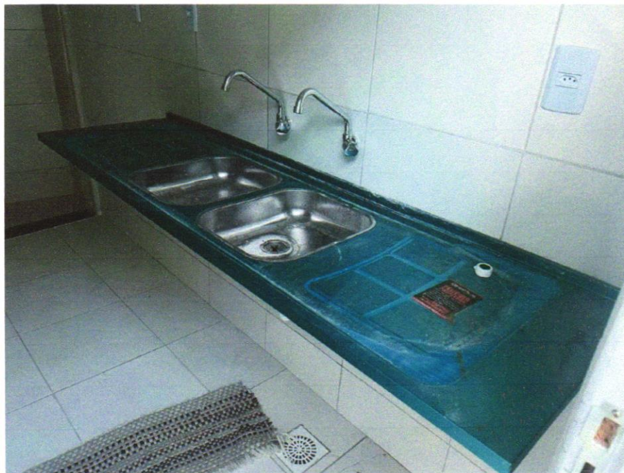
Foto 15 - Pia de cozinha com bancada em aço inox, dim 1,80x0,60, c/ 02 cubas, sifão cromado, válvula cromada, torneira cromada, concretada e assentada.
