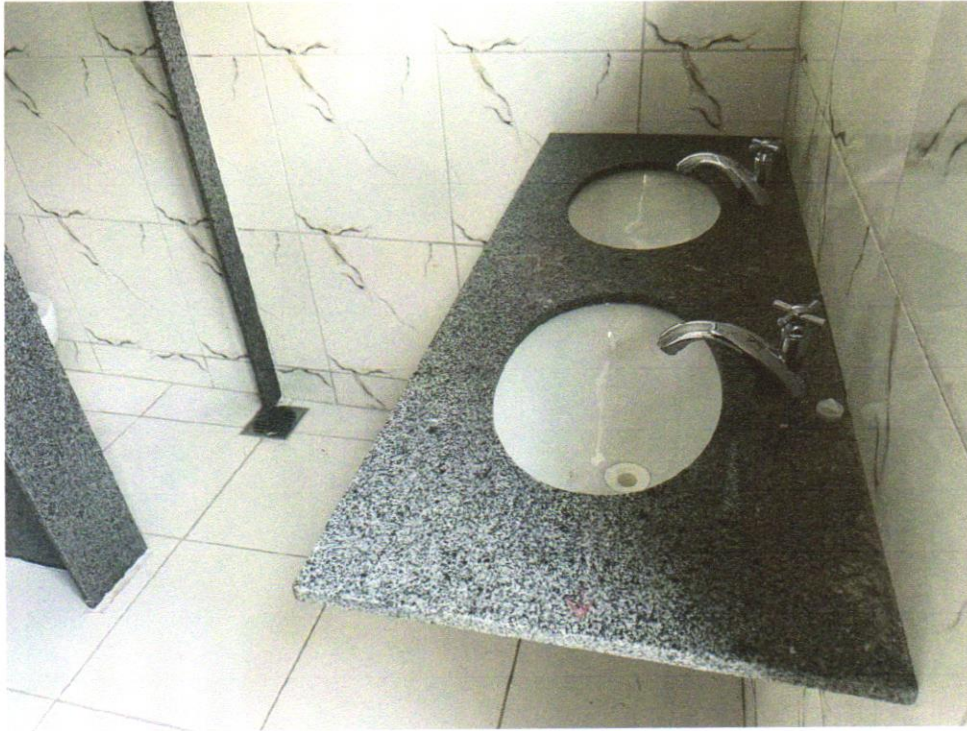
Foto 17 - Lavatório com bancada em granito cinza andorinha, e = 2cm, dim 1,25x0,60, com 02 cubas de embutir de louça, sifão cromado, válvula cromada, torneira cromada, inclusive rodopia 10 cm, assentada
