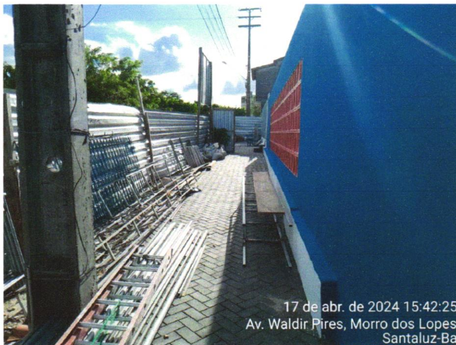
Foto 37 - APLICAÇÃO MANUAL DE PINTURA COM TINTA LÁTEX ACRÍLICA EM PAREDES, DUAS DEMÃOS. AF_06/2014
